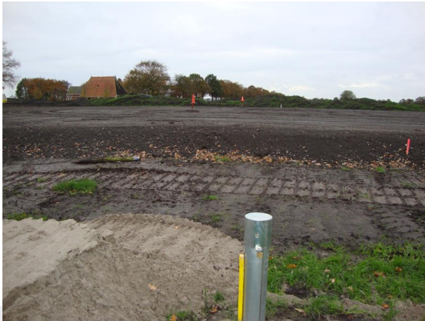
Foto: Bij 20: Monitoringsvoorziening: aanbrengen peilbuis.
